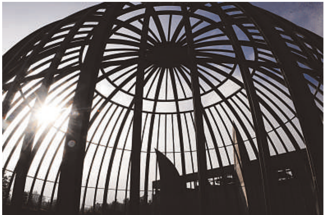
Sur le terrain du Heyritz, l'armature de la future coupole de la mosquée de Strasbourg. (Photo DNA - Cédric Joubert)
